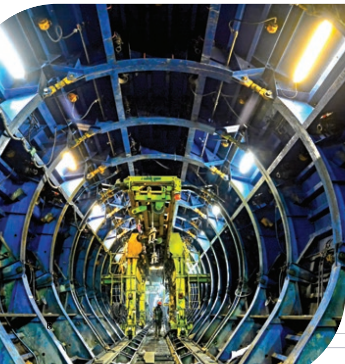
Túnel Emisor Oriente
