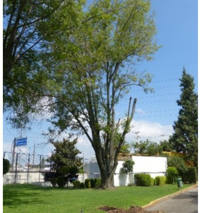
Vista Panorámica de la planta de tratamiento de Conducel
