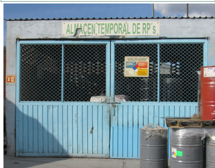
Almacén Temporal de Residuos Peligrosos de CONALUM.
