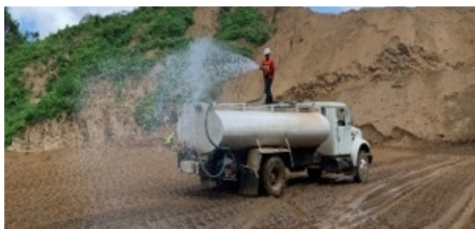
Uso de agua, para el riego de caminos en el proyecto de las Varas-Vallarta
